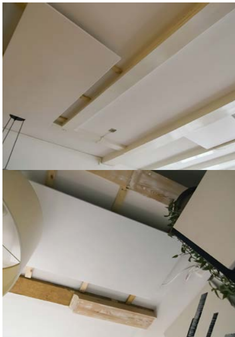
Infraroodpanelen tussen de oude balken
