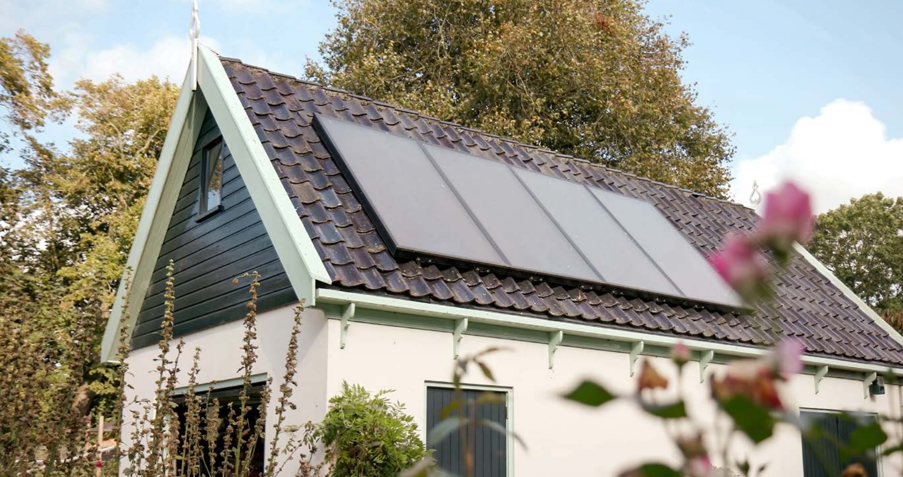
Polderhuis Wieringerwaard Zonnepanelen op (niet monumentaal) bijgebouw
